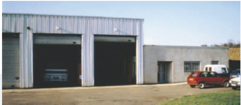
Les ateliers techniques municipaux.
