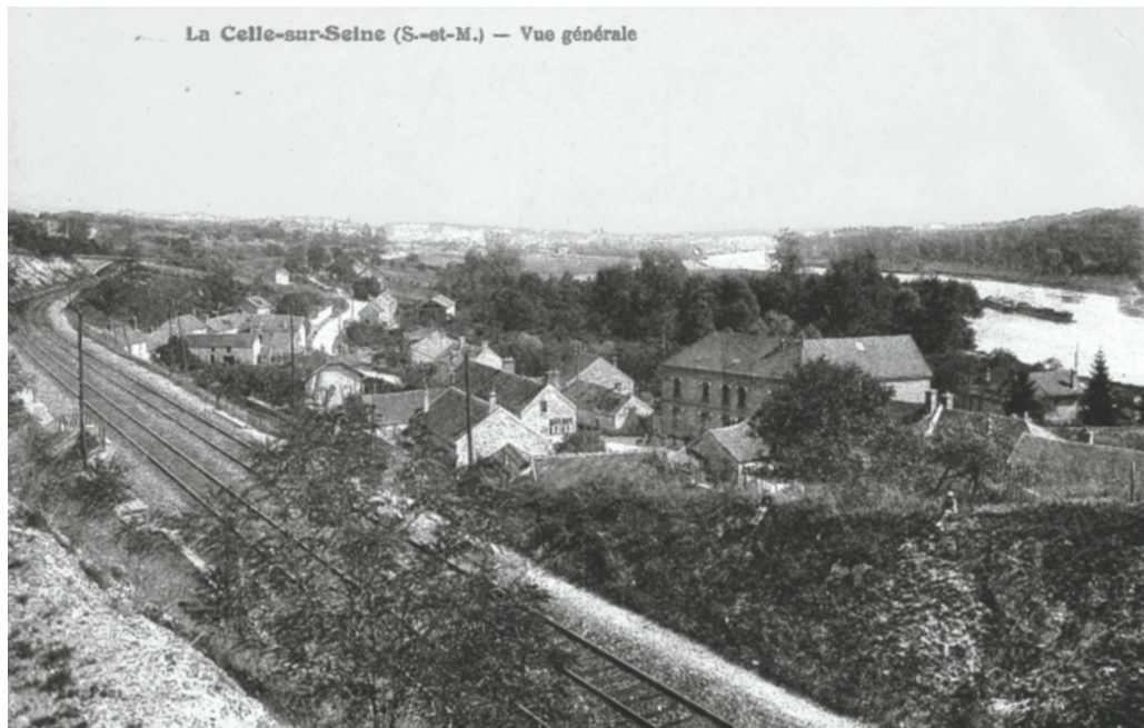
1950 Vue générale avant l'électrification de la voie ferrée.
