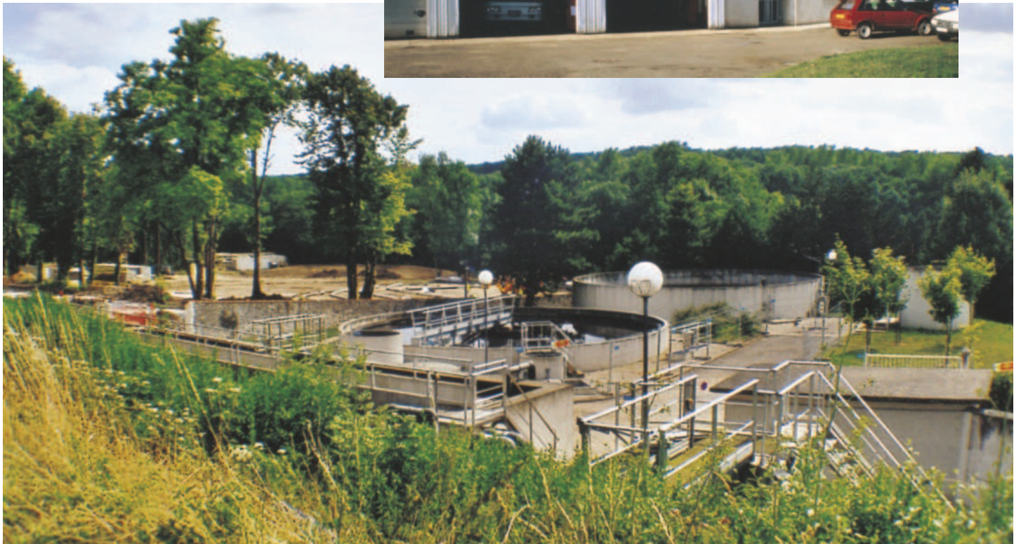
La station d'épuration (inaugurée en 1995).
